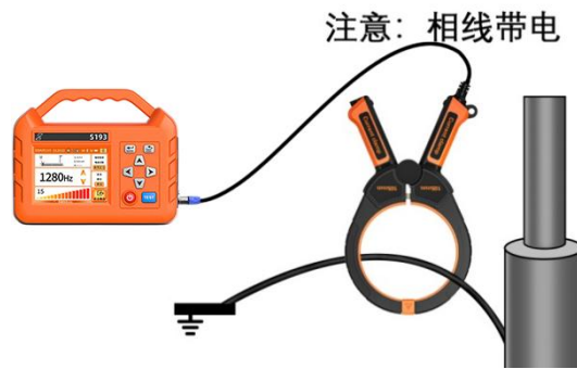
图 24 运行电缆卡钳耦合法 2（卡电缆接地线）
